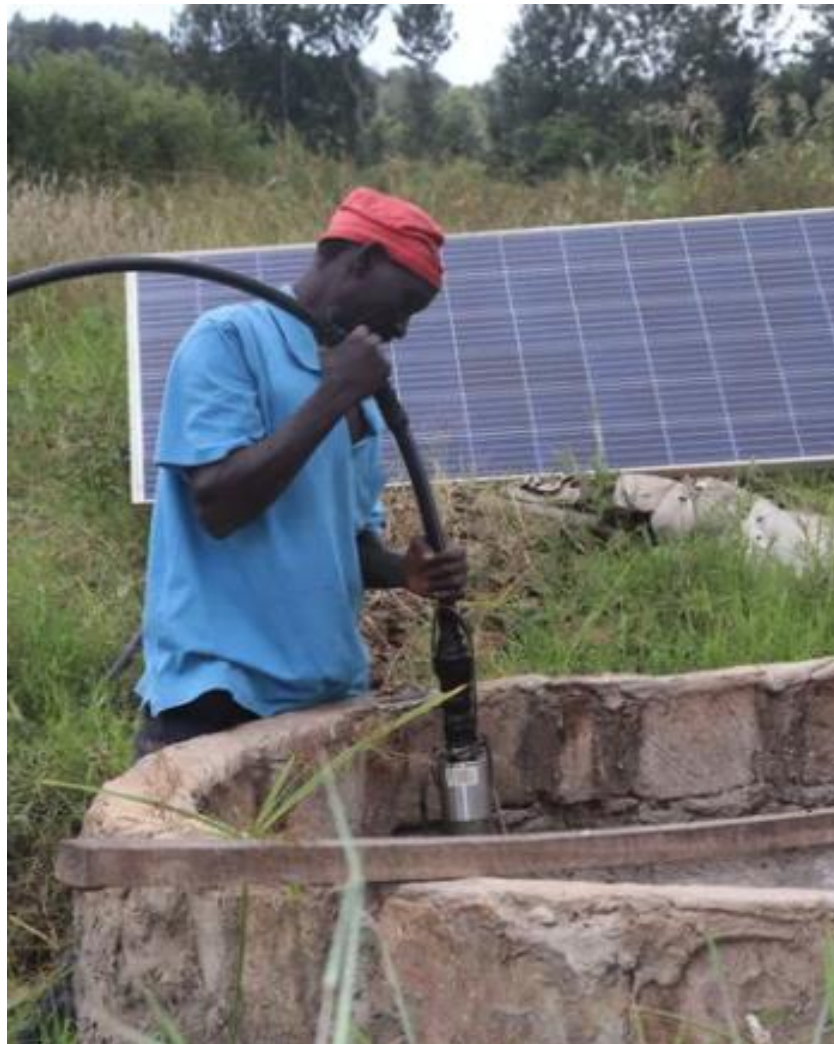
Рисунок 24 – Встановлення сонячного водяного насоса в Кенії
