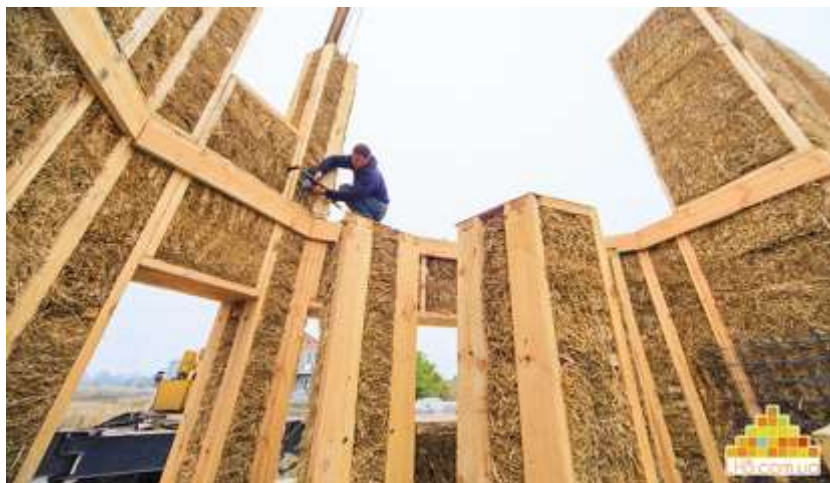
Рисунок 9.29 – «Солом'яний будинок» в процесі будівництва (Аббасова, 2017)
