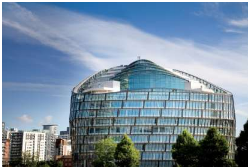
Рисунок 9.10 – Будівля One Angel Square в Манчестері (Англія) (Город, 2016)
