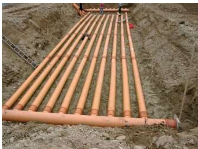
Рисунок 5.1 – Труби для збирання підземного тепла/прохолоди (Закопана, 2015)
